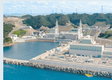
島根原子力発電所
