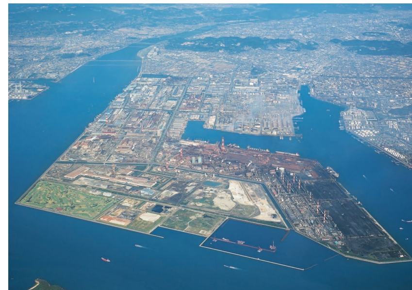
高効率電気炉を建設中のJFEスチール西日本製鉄所（倉敷地区）
