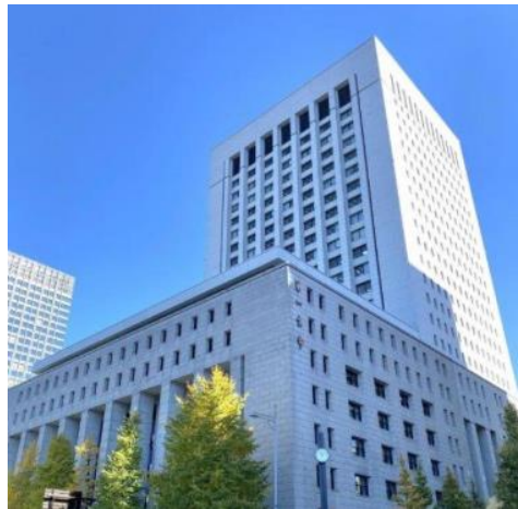
入居ビル (第一生命日比谷ファーストビル)
